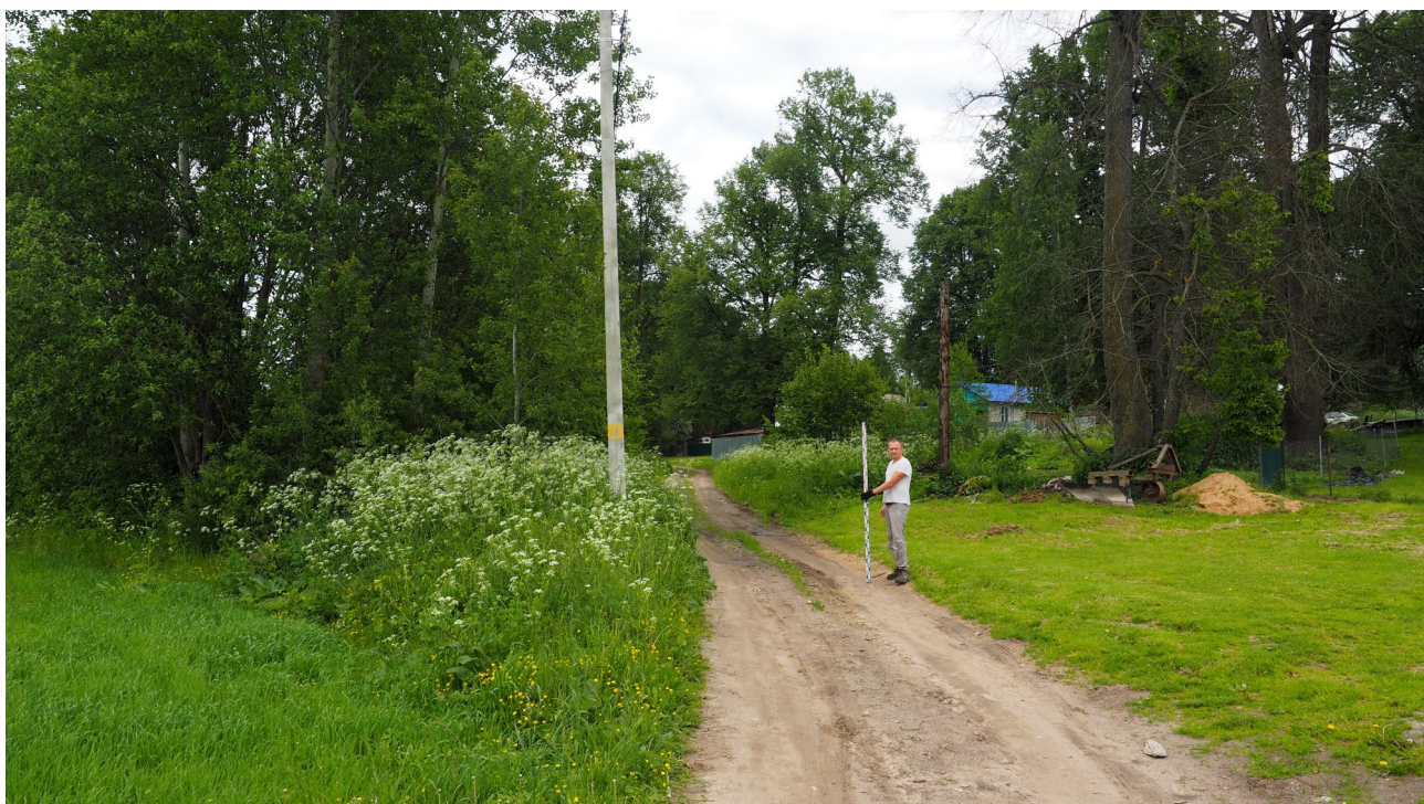
Рис. 33. Калужская область, Спас-Деменский район. 2023 г. Археологическое обследование по объекту: «Уличные газопроводы дер. Павлиново». Точка фотофиксации № 14. Вид с юго-запада.
